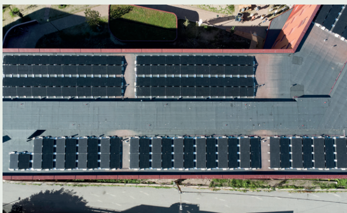
Lund Torv har 400 kvadratmeter med solceller på takene.
