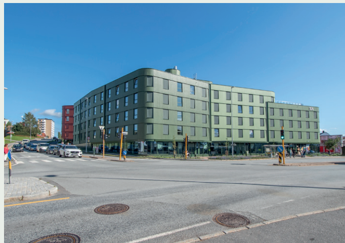
Prosjektet er bygget tett på et trafikkert kryss med krevende grunnforhold.
